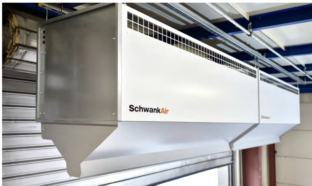
Torluftschleier von Schwank: SchwankAir
