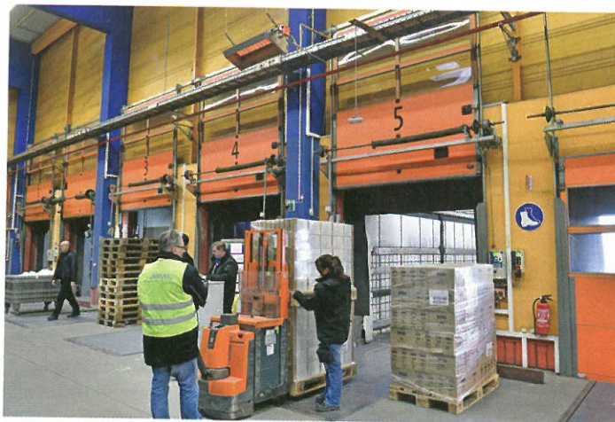
Am „Check in“, wo die Tore quasi dauerhaft offenstehen, wärmt ein Hellstrahler den Einzelarbeitsplatz.
