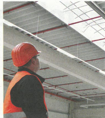
Das Brennwertsystem tetraSchwank nutzt Wärmeenergie aus dem Abgas und führt sie dem Raum direkt wieder zu.
